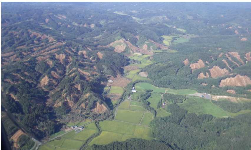
写真-1 北海道胆振東部地震に伴う斜面崩壊
