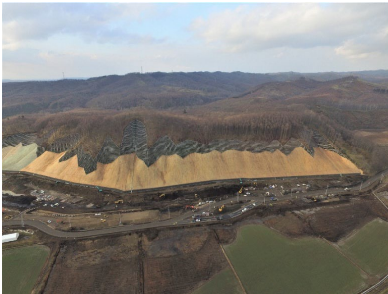
写真一 2 斜面崩壊箇所の復旧工事例
