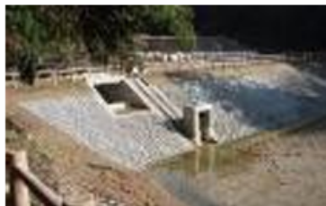
農業用ため池の整備
