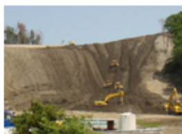
対策工事のイメージ
