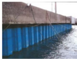
岸壁、鋼製矢板の腐食対策
